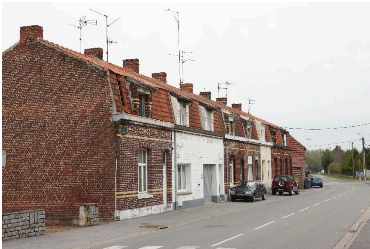
Maisons ouvrières en série, 22-36, rue de Maulde.
