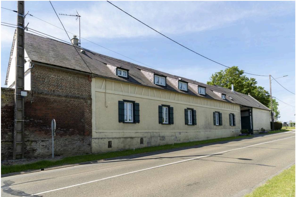
Vue du logis depuis le nord-est, sur la route de Rouen.
