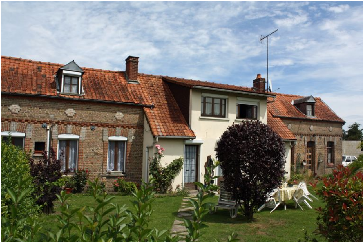
Vue d'ensemble des trois logements, façade sur jardin.
