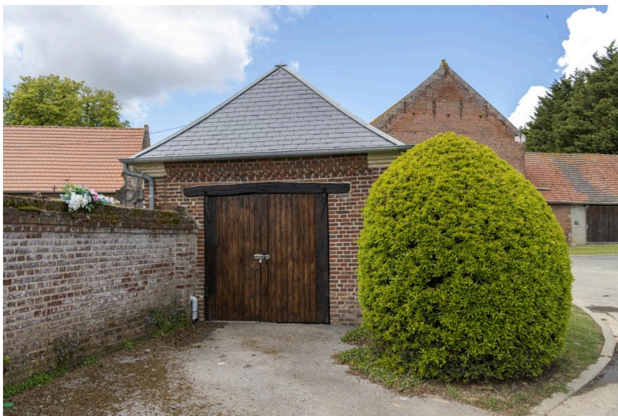
Bâtiment des pompes à incendie, vers 1901.
