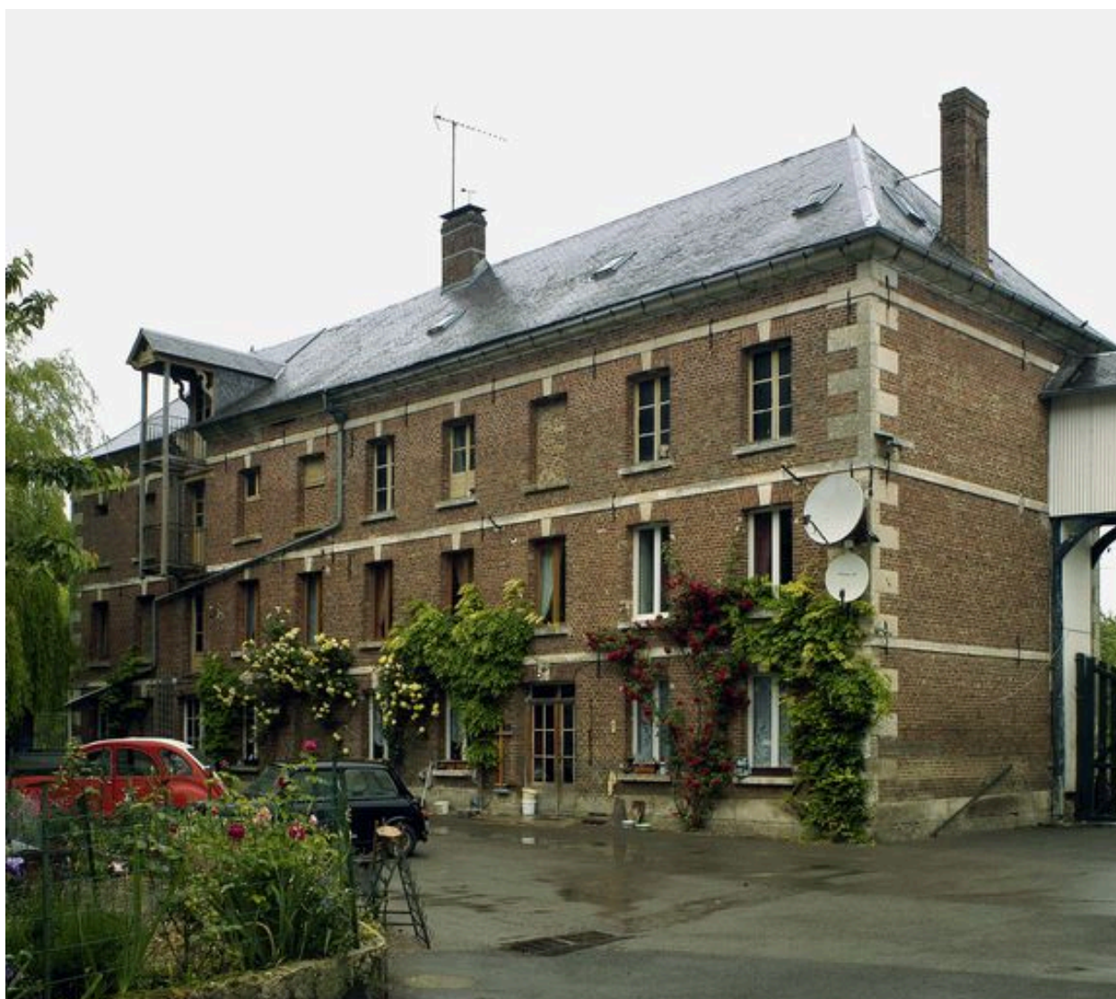
Façade sur cour de la minoterie.
