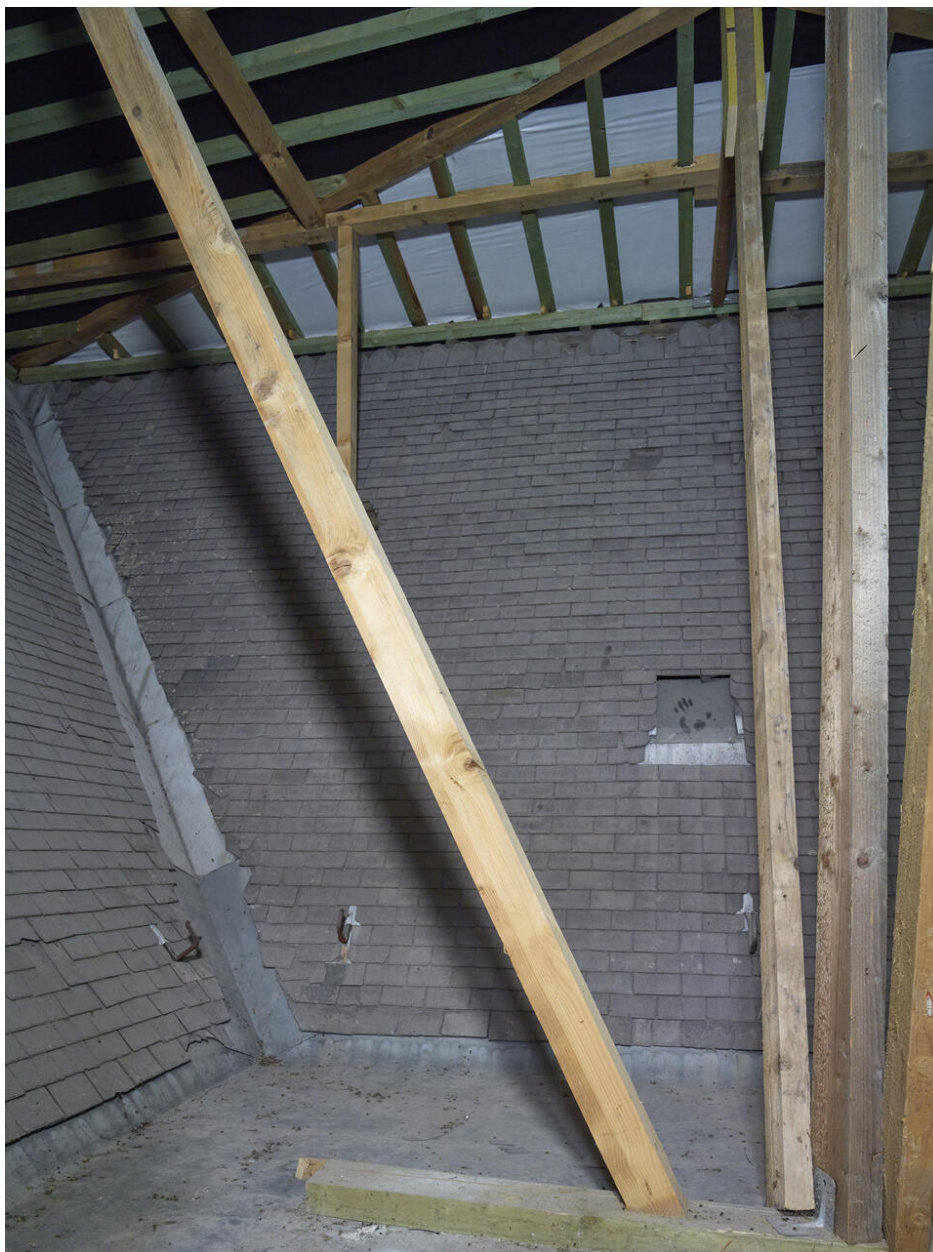
Détail de la toiture et de la noue intérieure de réception des eaux pluviales.
