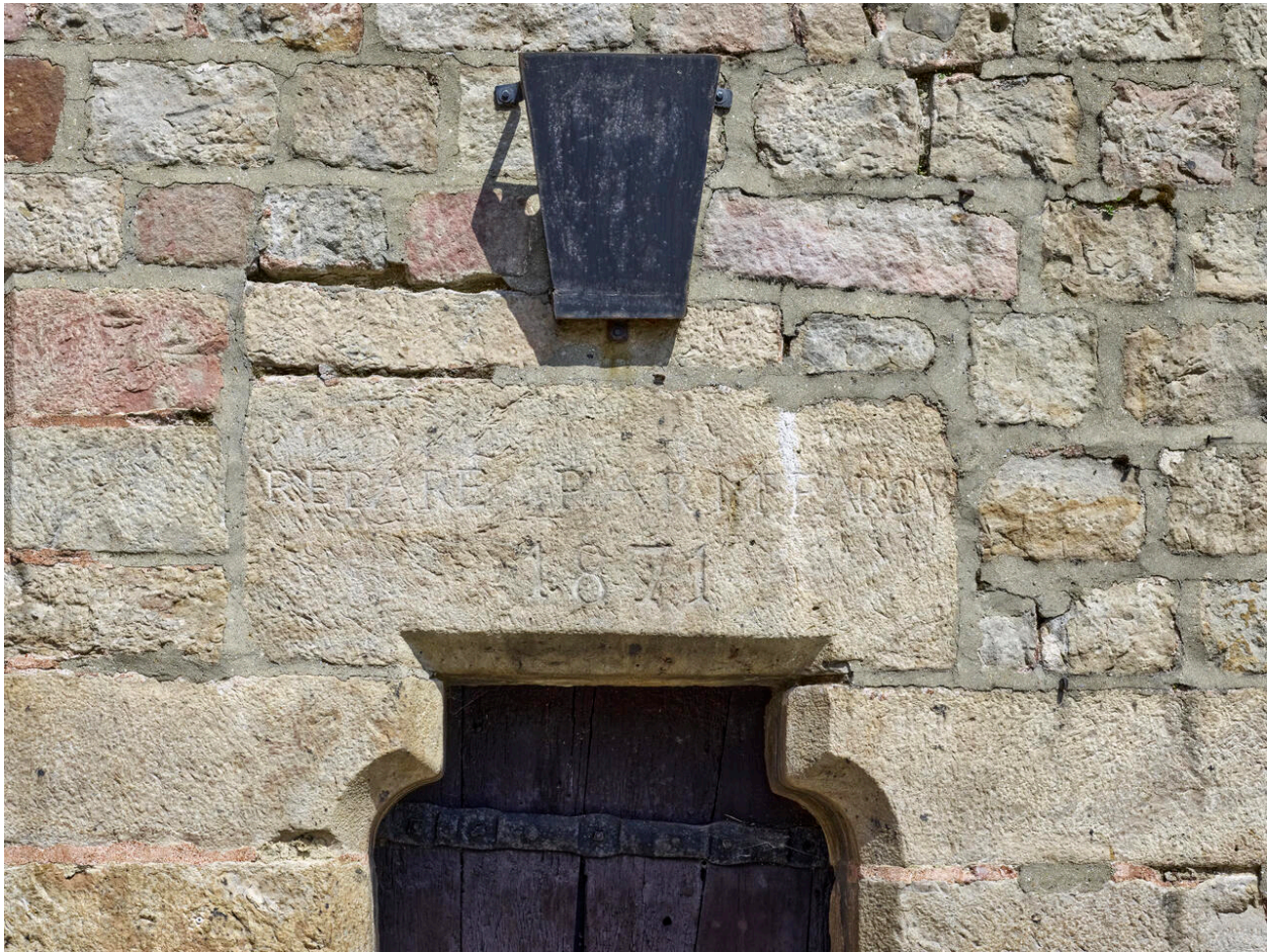
Détail du linteau de l'entrée sud indiquant la réparation de l'édifice par Farcy en 1871.
