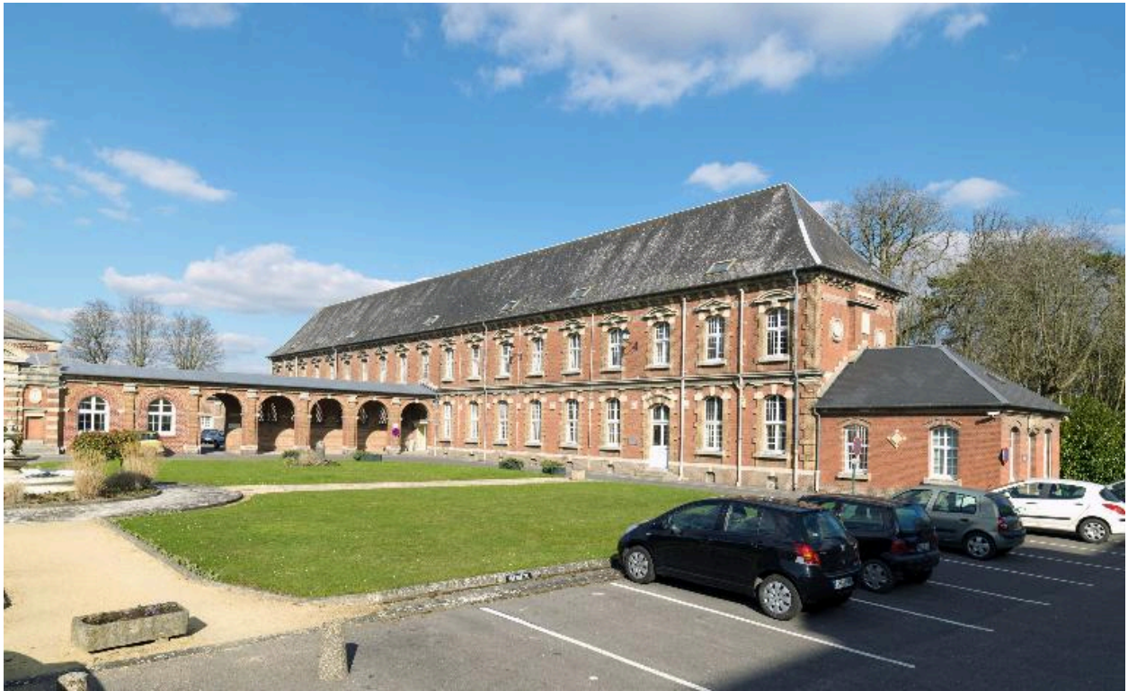
Ancien pensionnat. L'ancien pavillon des hommes.
