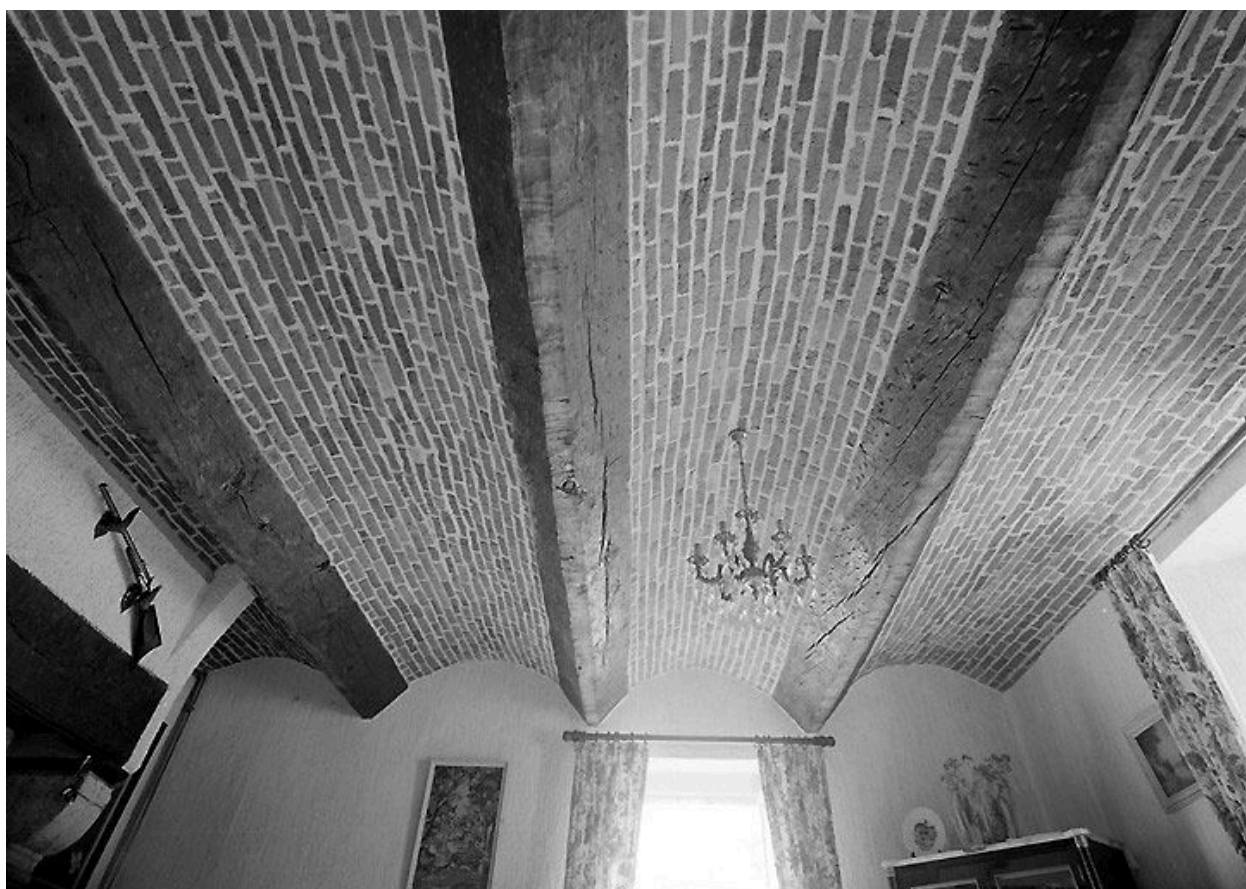
Pièce principale du rez-de-chaussée : entrevous en berceau segmentaire.
