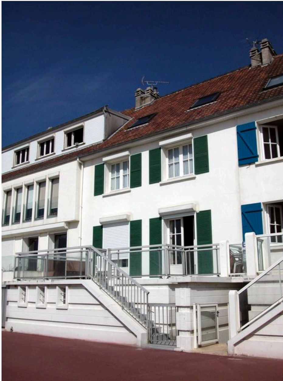
102 boulevard maritime sud (Faraon), façade sur mer.
