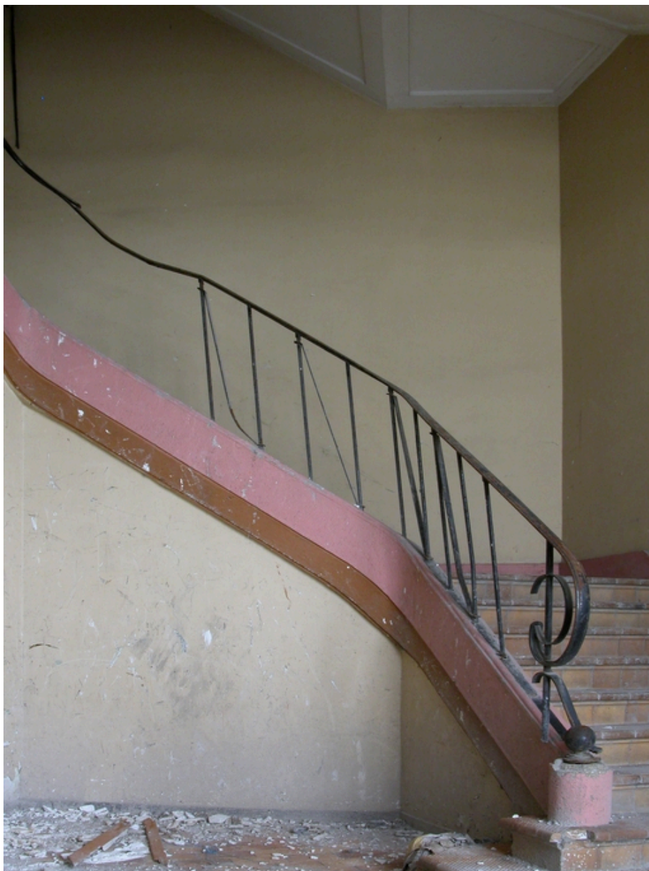
Escaliers des ateliers des années 1946-48.
