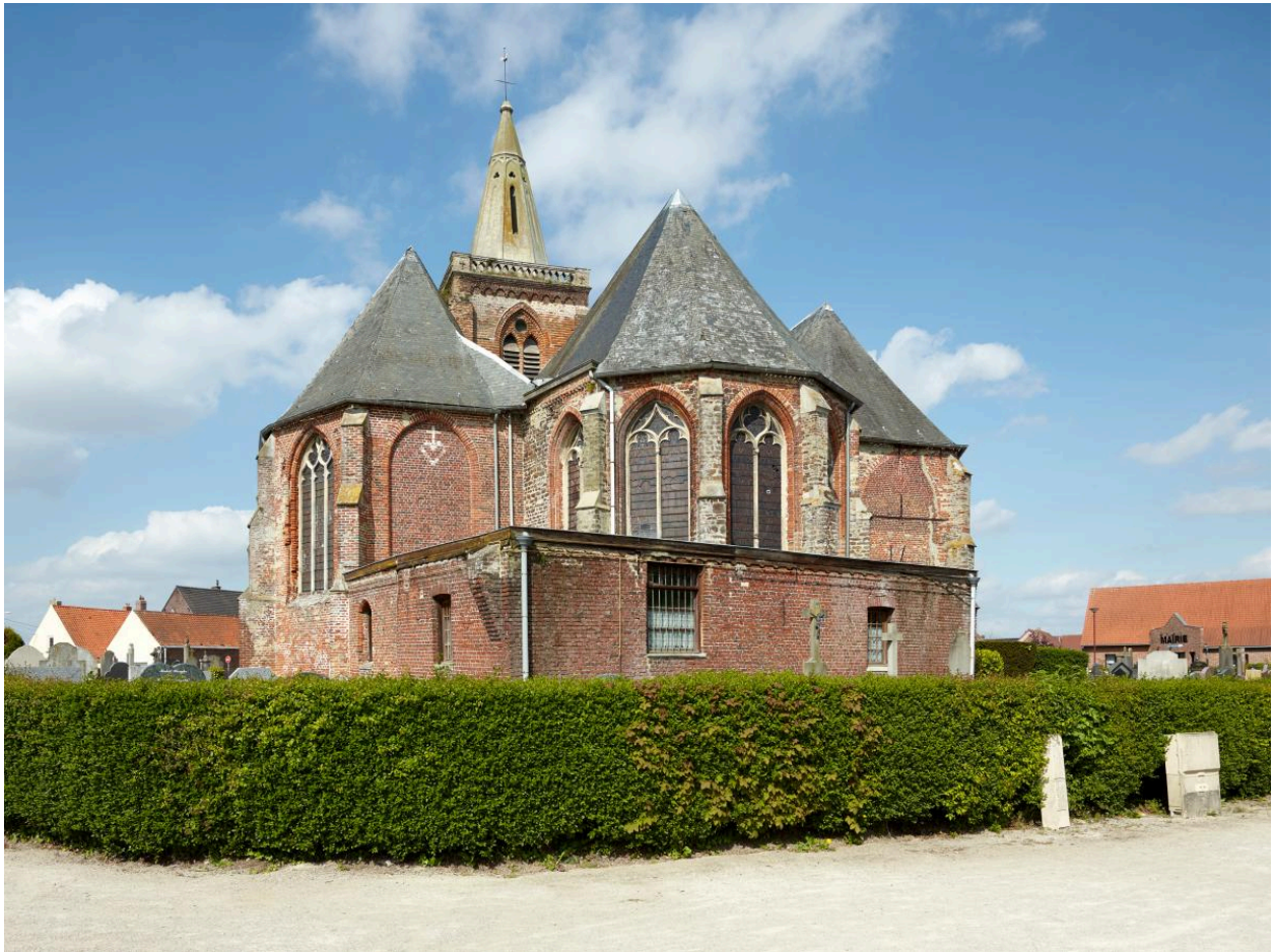
Vue générale depuis l'est.
