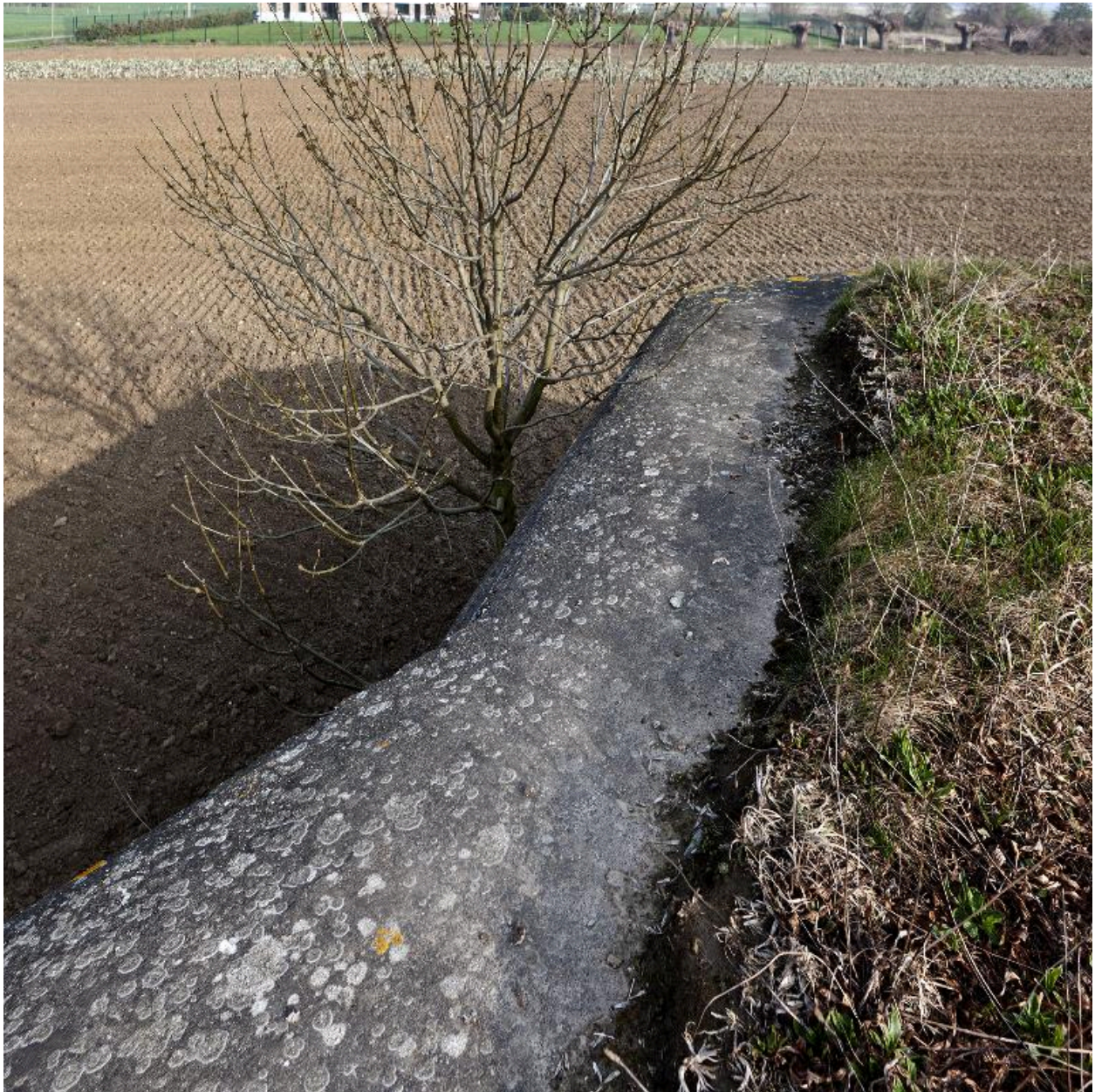
Vue en surplomb et vers le front depuis la position de mitrailleuse.
