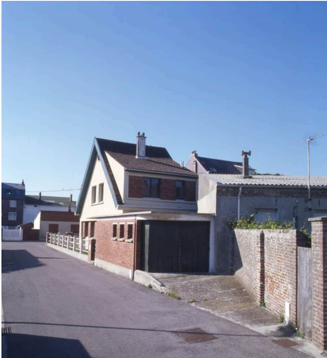
Vue d'ensemble depuis l'impasse Sainte-Catherine.
