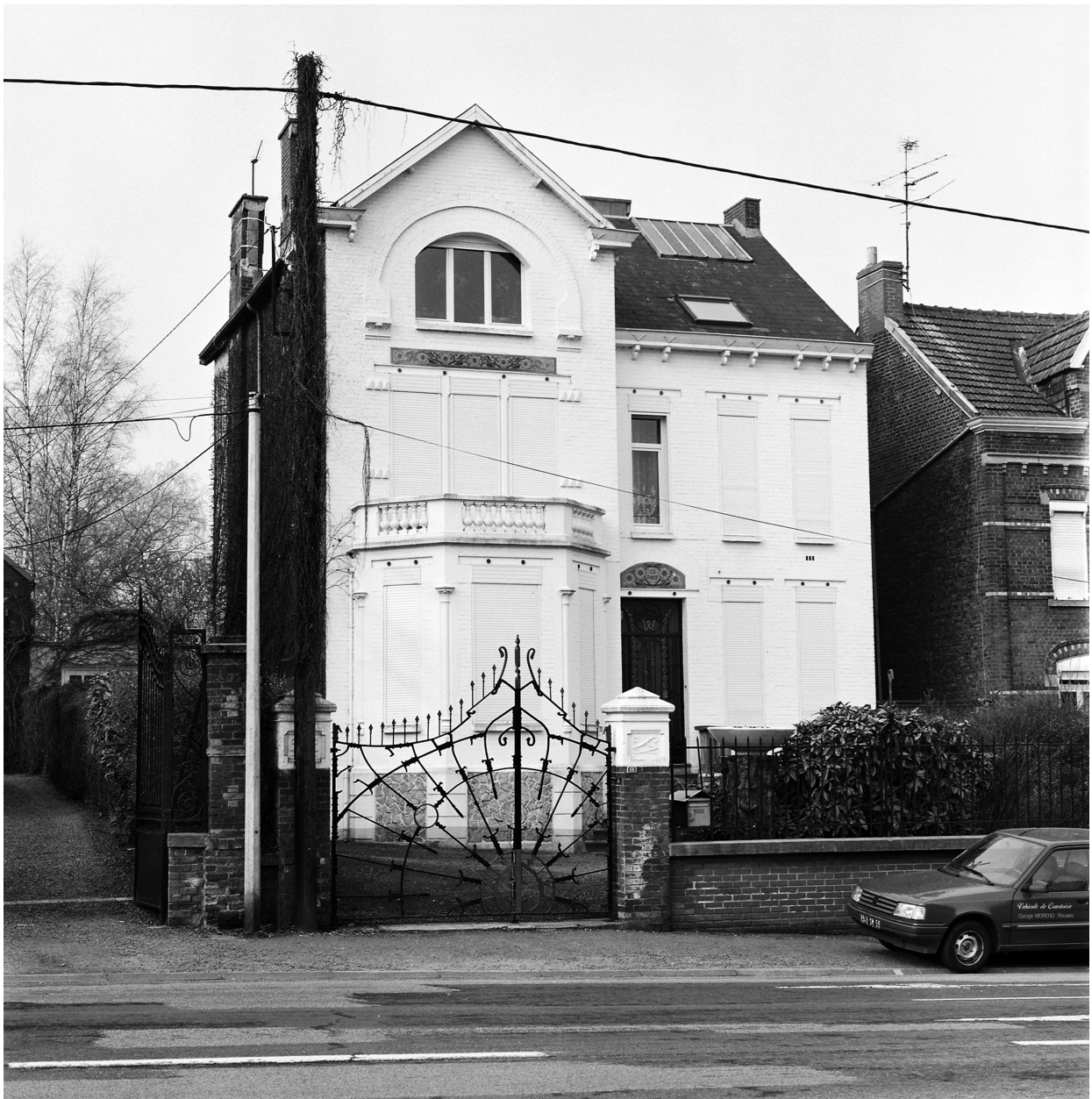
Vue générale de l'élévation antérieure.
