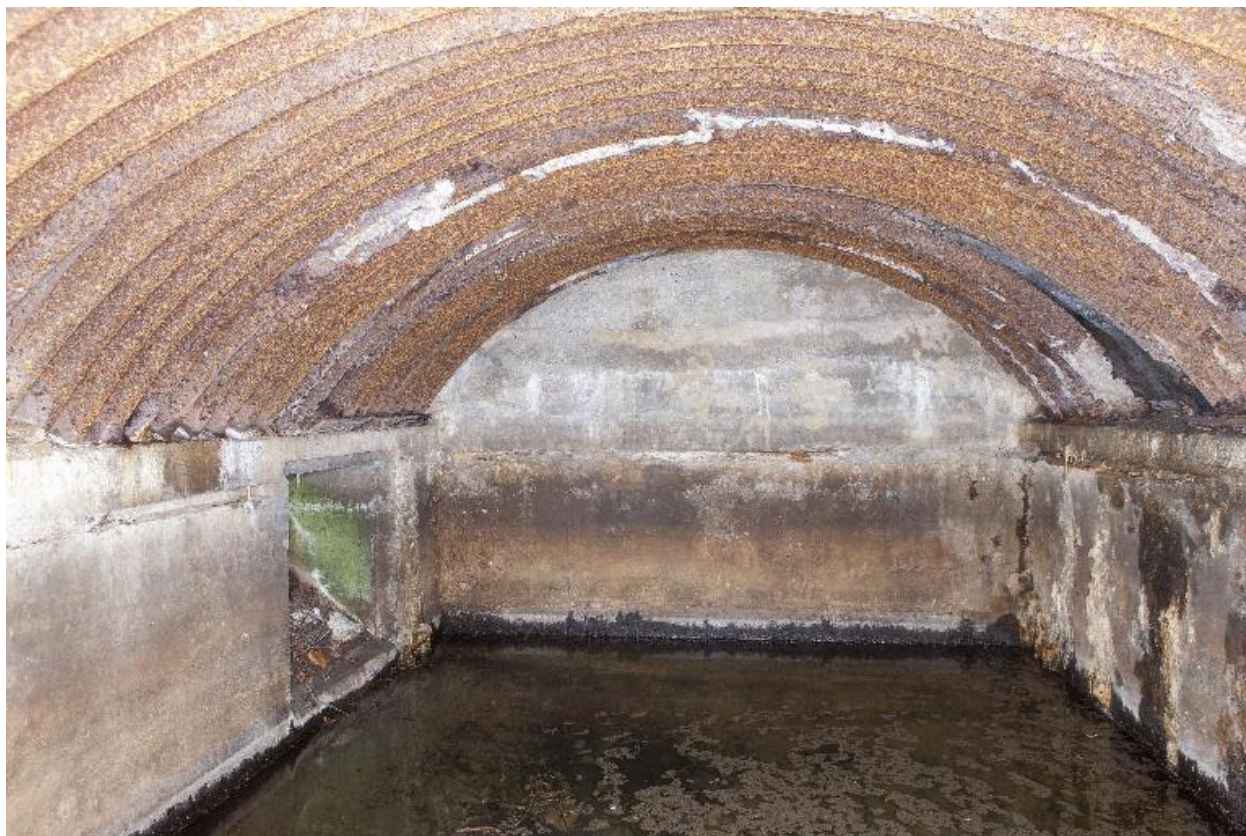
Vue intérieure de l'abri à personnel. A gauche le toboggan à mitrailleuse
