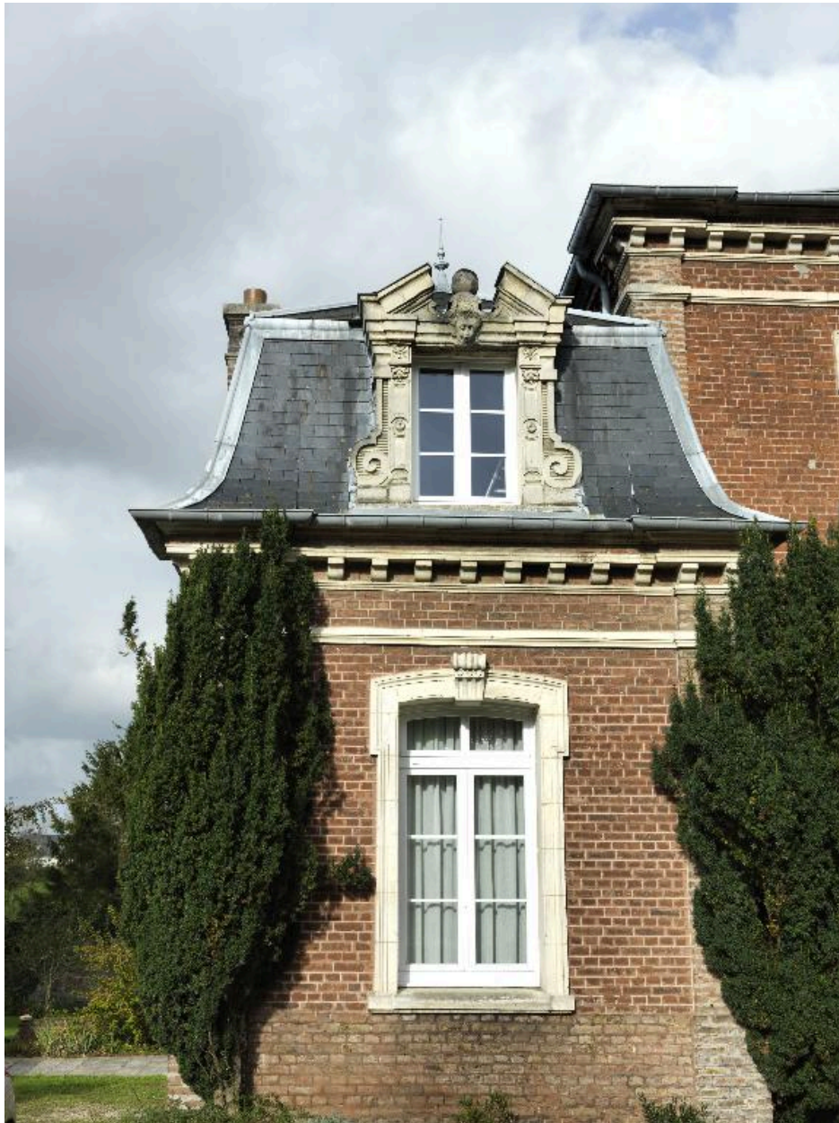
Détail de la lucarne.
