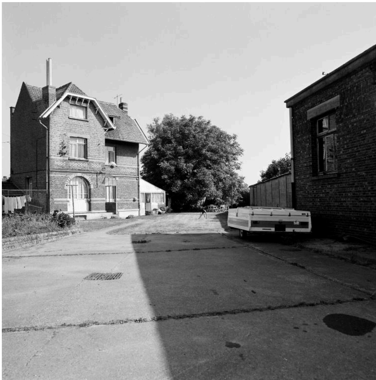
Conciergerie nord et, à sa droite, l'ancien embranchement ferroviaire. Vue prise vers le nord.
