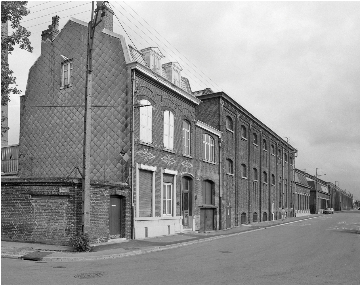
Élévation antérieure rue Roger-Salengro. Vue prise vers le sud-est. Au premier plan, l'ancienne maison du directeur et un magasin industriel.
