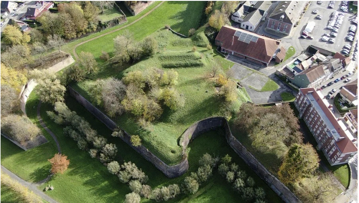
Vue aérienne orientée nord-est/sud-ouest : bastion César et immeuble Seconde Reconstruction (ancienne caserne Montplaisir).
