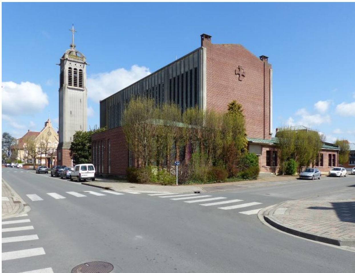
Vue générale, depuis le sud-ouest.
