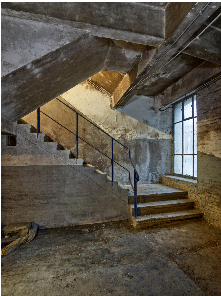
Bâtiment A, escalier en béton desservant les étages.
