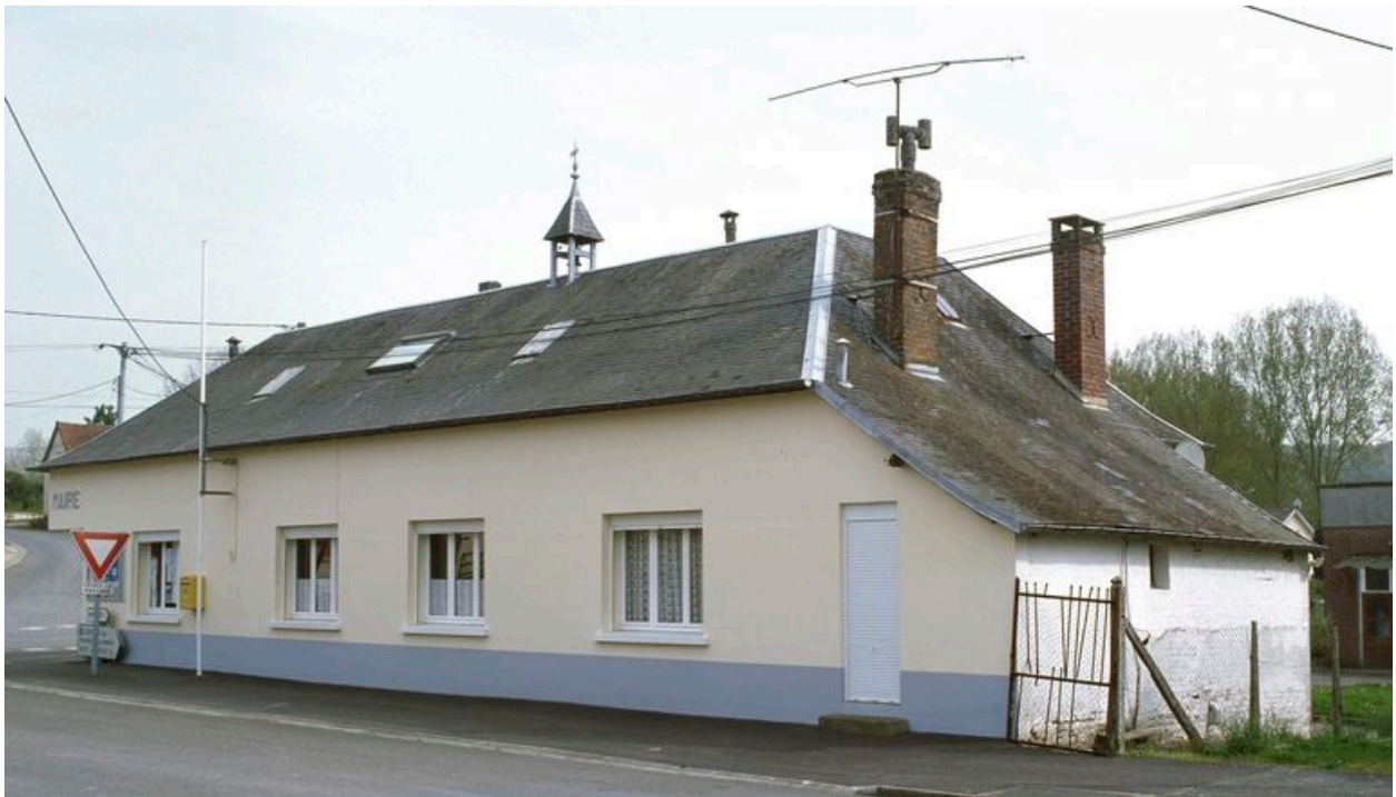
Vue générale depuis le nord-ouest.
