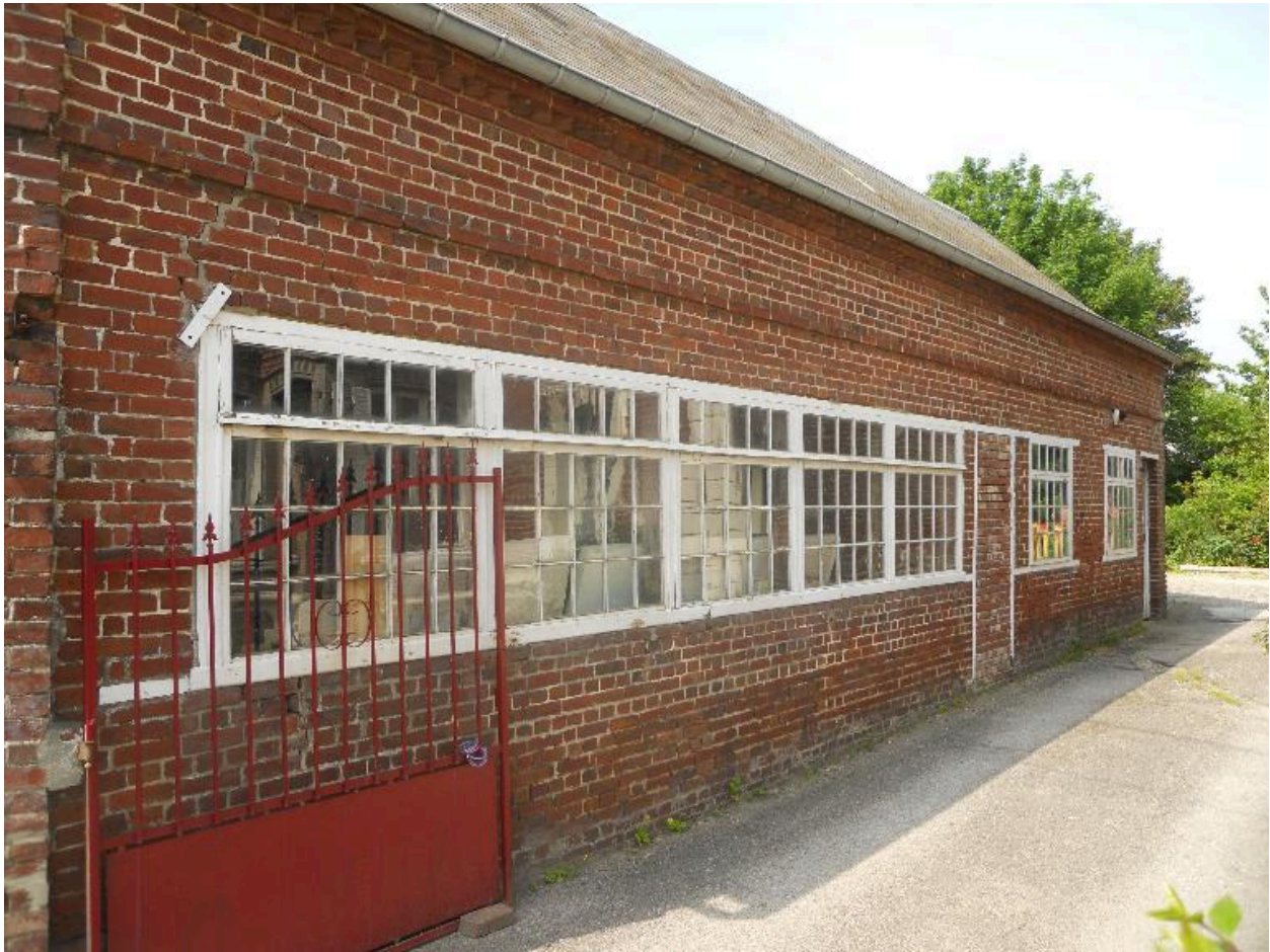
Vue de l'ancienne fabrique de cadenas.
