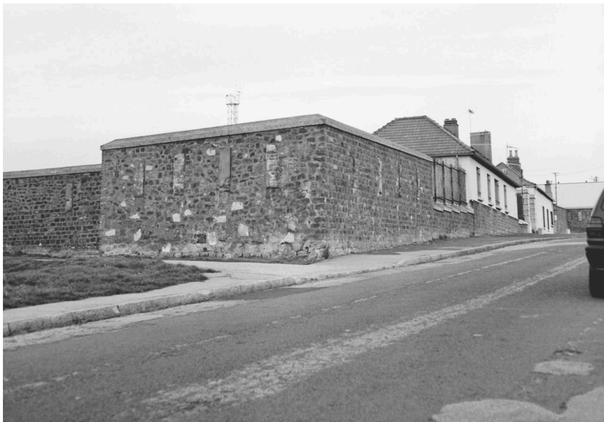
Vue d' angle sud est.
