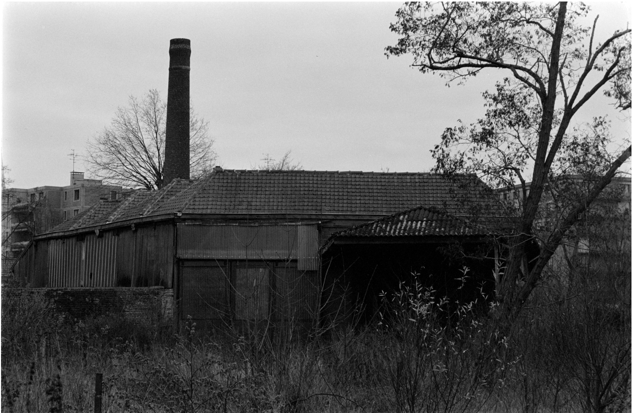
Magasin industriel. Vue prise vers le sud.
