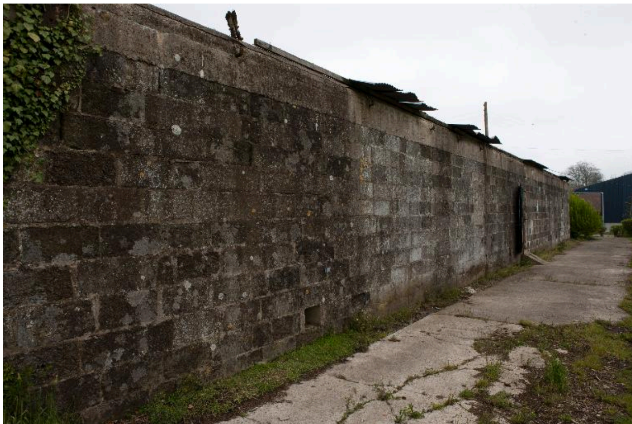
Bâtiment de stockage d'attente. Détail de l'élévation.
