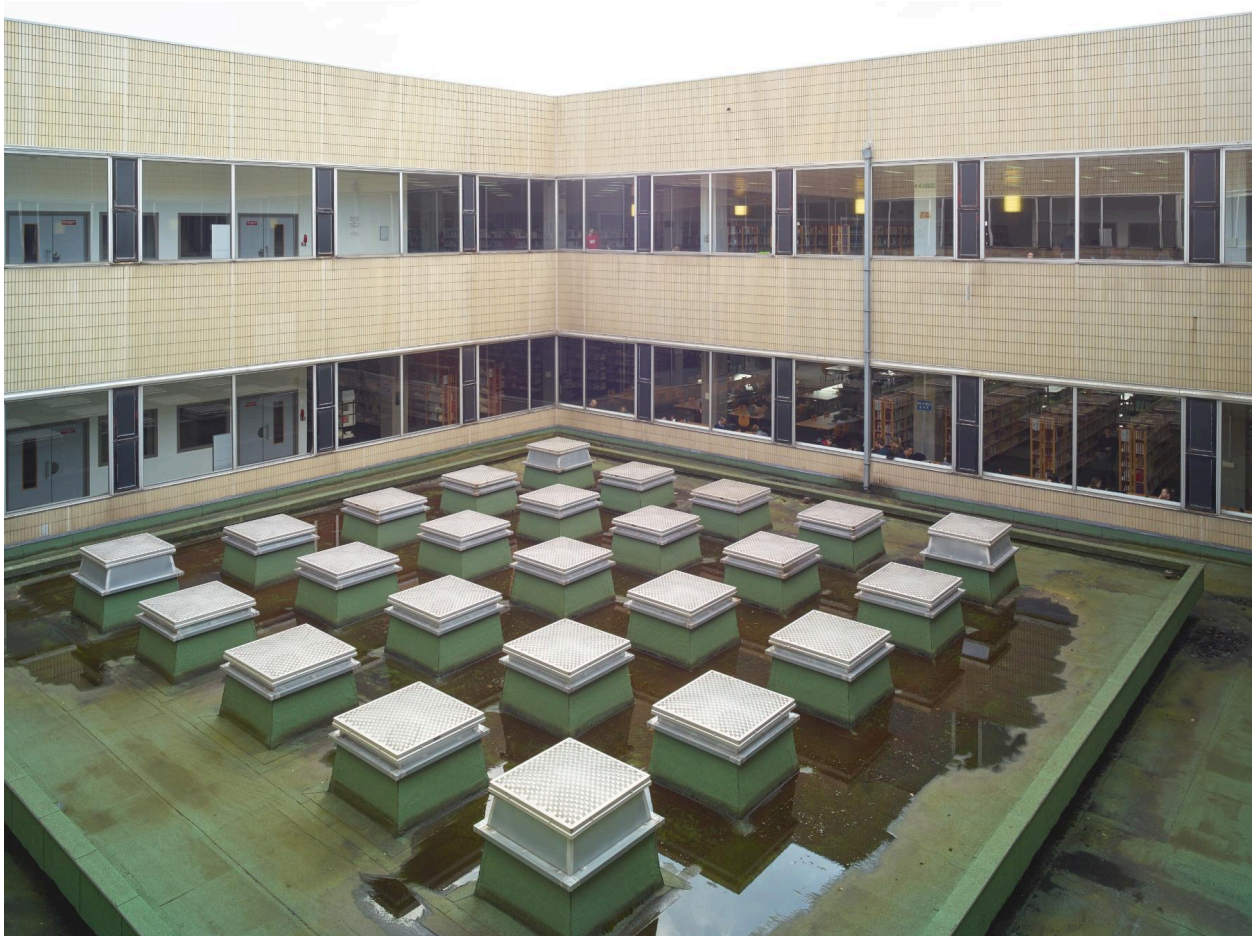
Vue des salles de travail sur le patio, qui éclaire le hall d'entrée, situé au-dessous.
