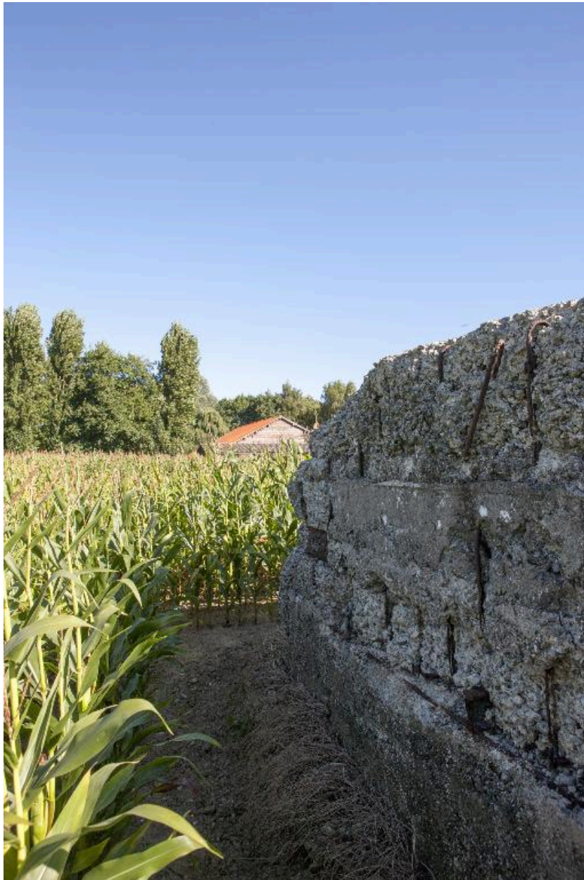
Elévation nord, vers l'est
