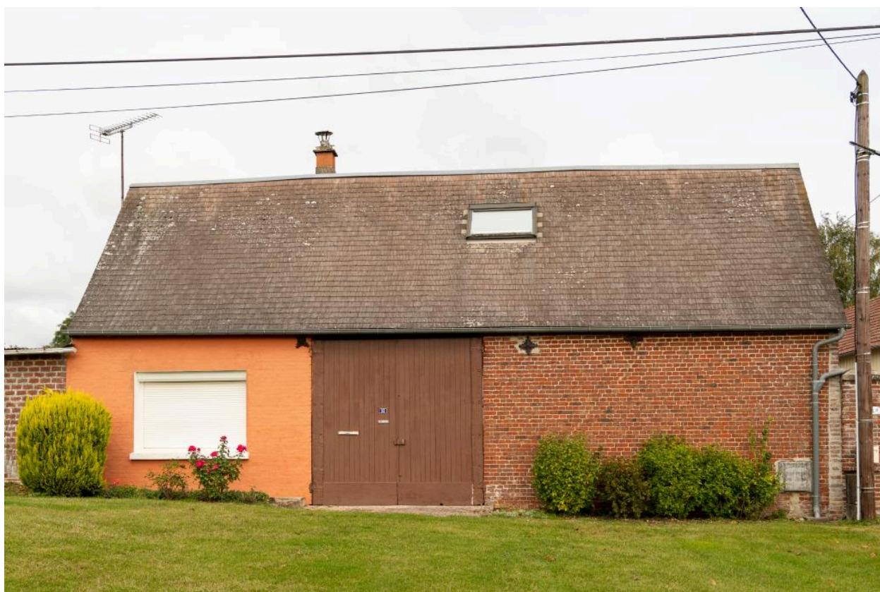
Grange en brique avec ancien atelier de serger (?) réaménagée en partie, n°10 rue de la Sablonnière, vue depuis le sud.
