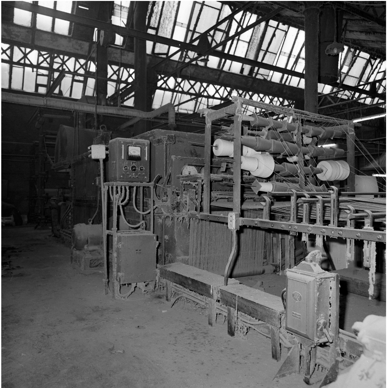
Préparation avant tissage. Encolleuse (Joseph Hibbert & Company, Darwen (GB)).
