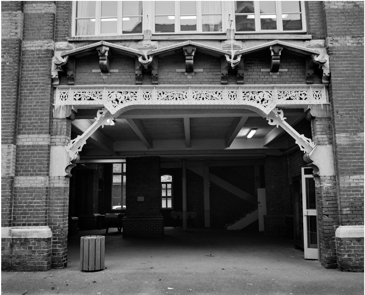
Deuxième travée (depuis la rue) du rez-de-chaussée de l'école primaire : poutrelles de fonte décorées d'oiseaux, de loutres (?) et de chenilles.
