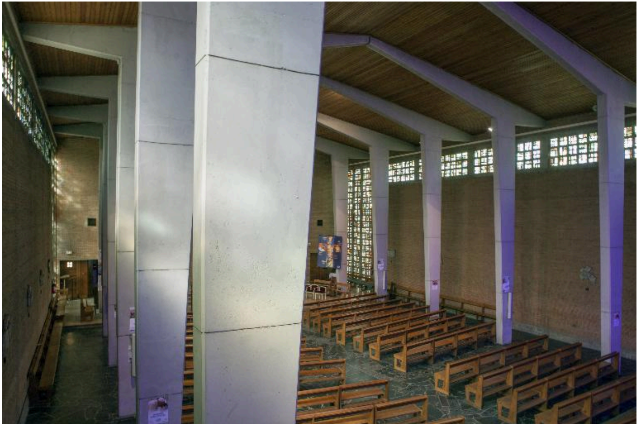
Vue, depuis la tribune, des piliers de l'église.
