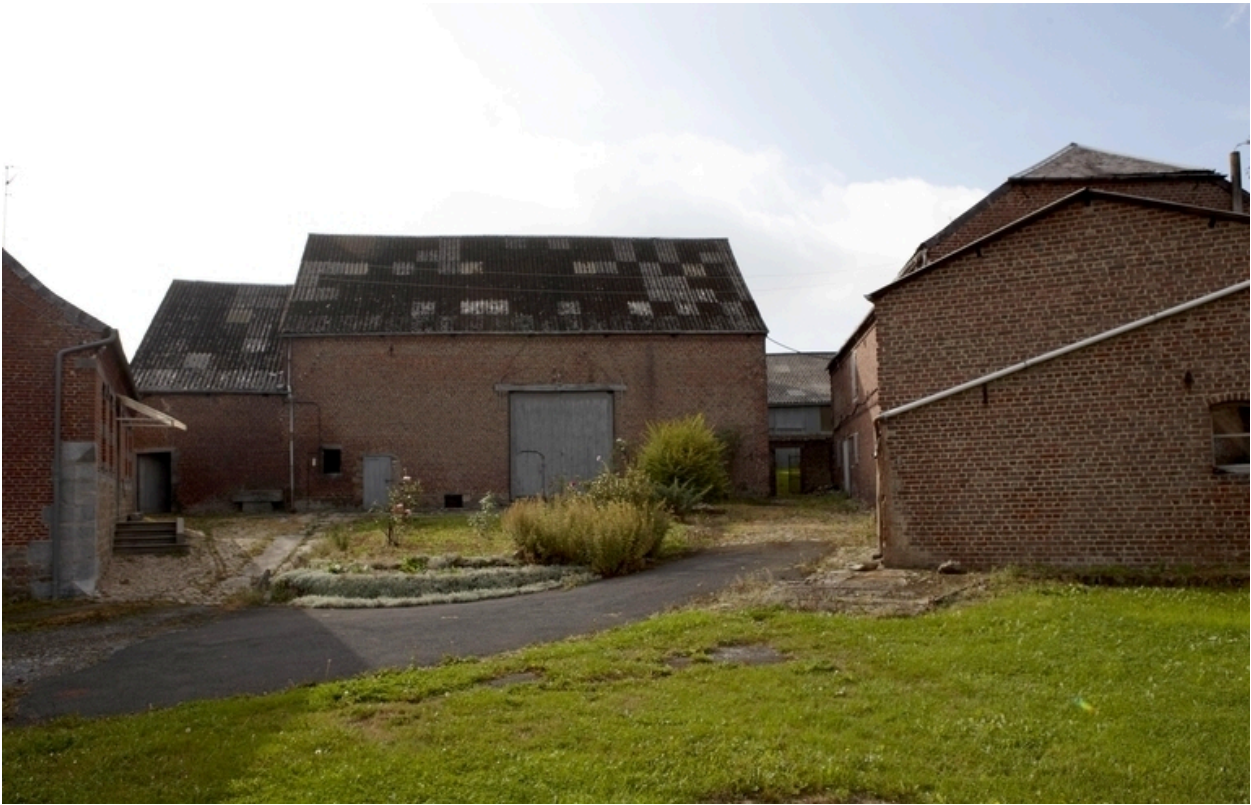
Vue générale, avec l'étable et la grange.
