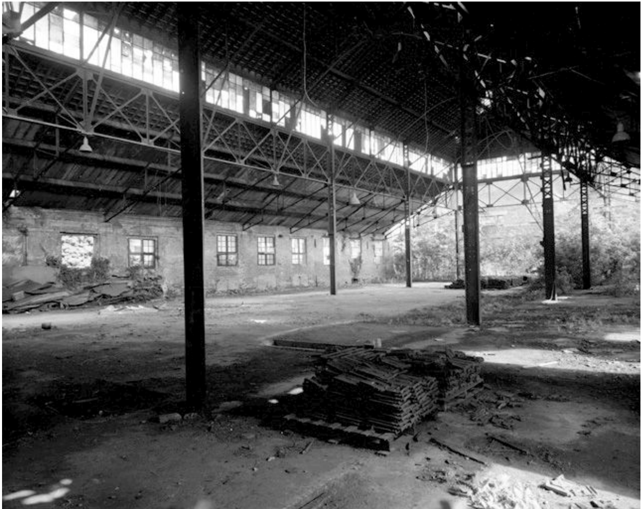
Atelier de fabrication, vue intérieure partielle, en 1988.
