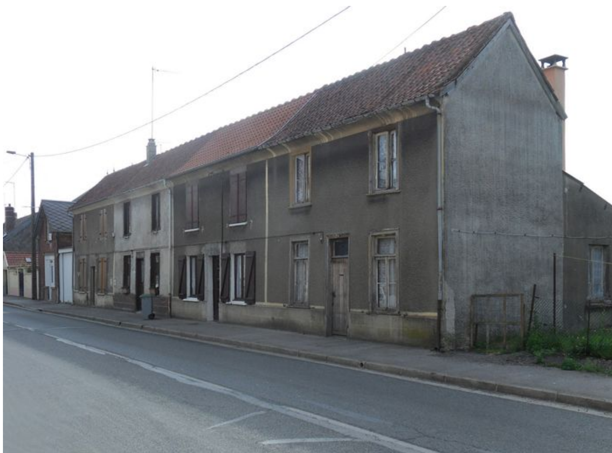
Vue générale, depuis le sud.
