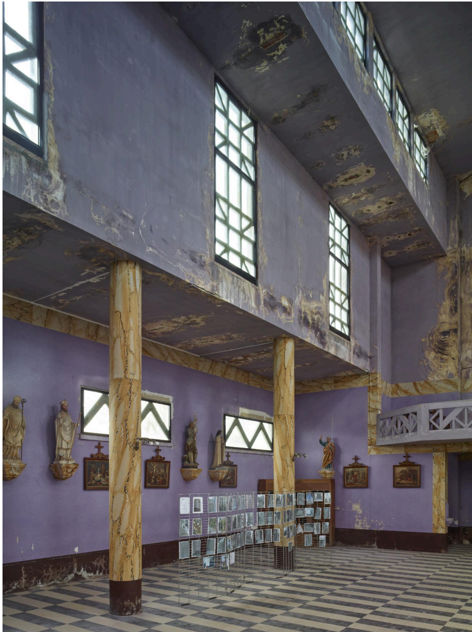
Vue du bas côté sud, depuis le chœur.
