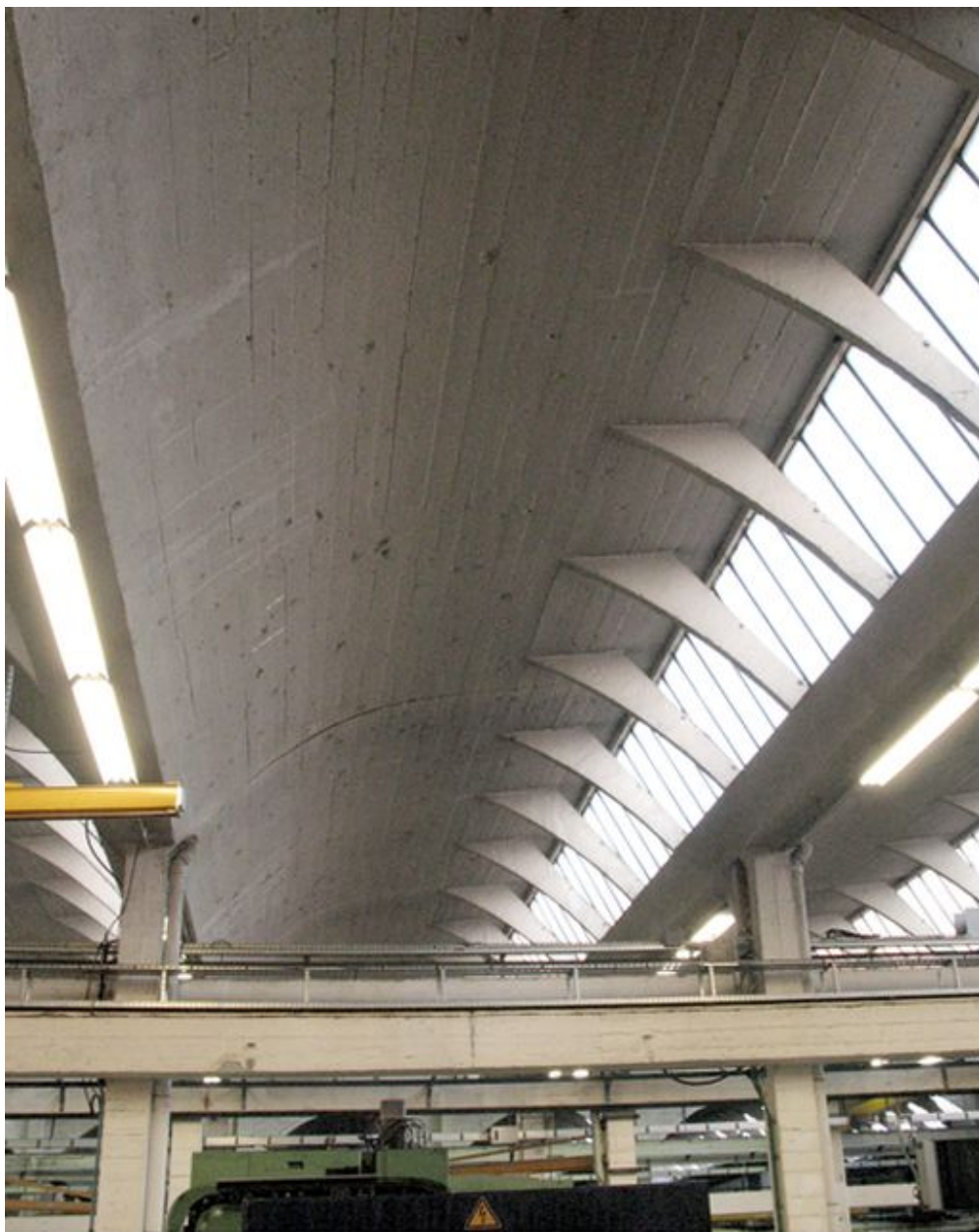
Détail de la structure des sheds.
