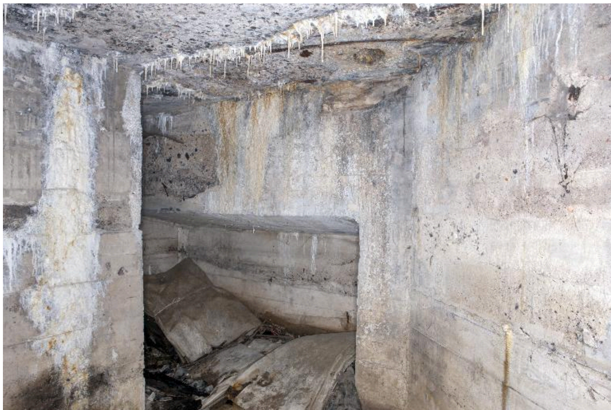
Salle sud et mur de refend, à gauche
