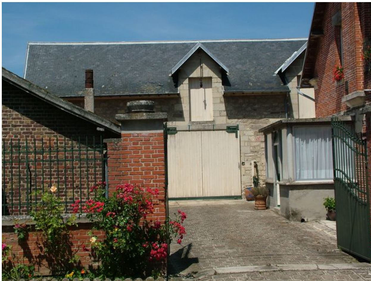
Vue de la grange.
