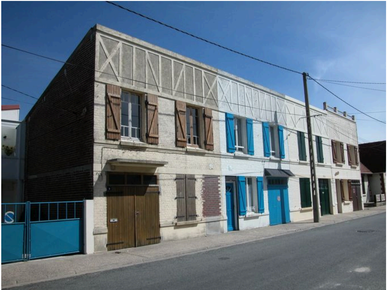
Toits à un pan (3 à 9 rue Bazile-Capet).
