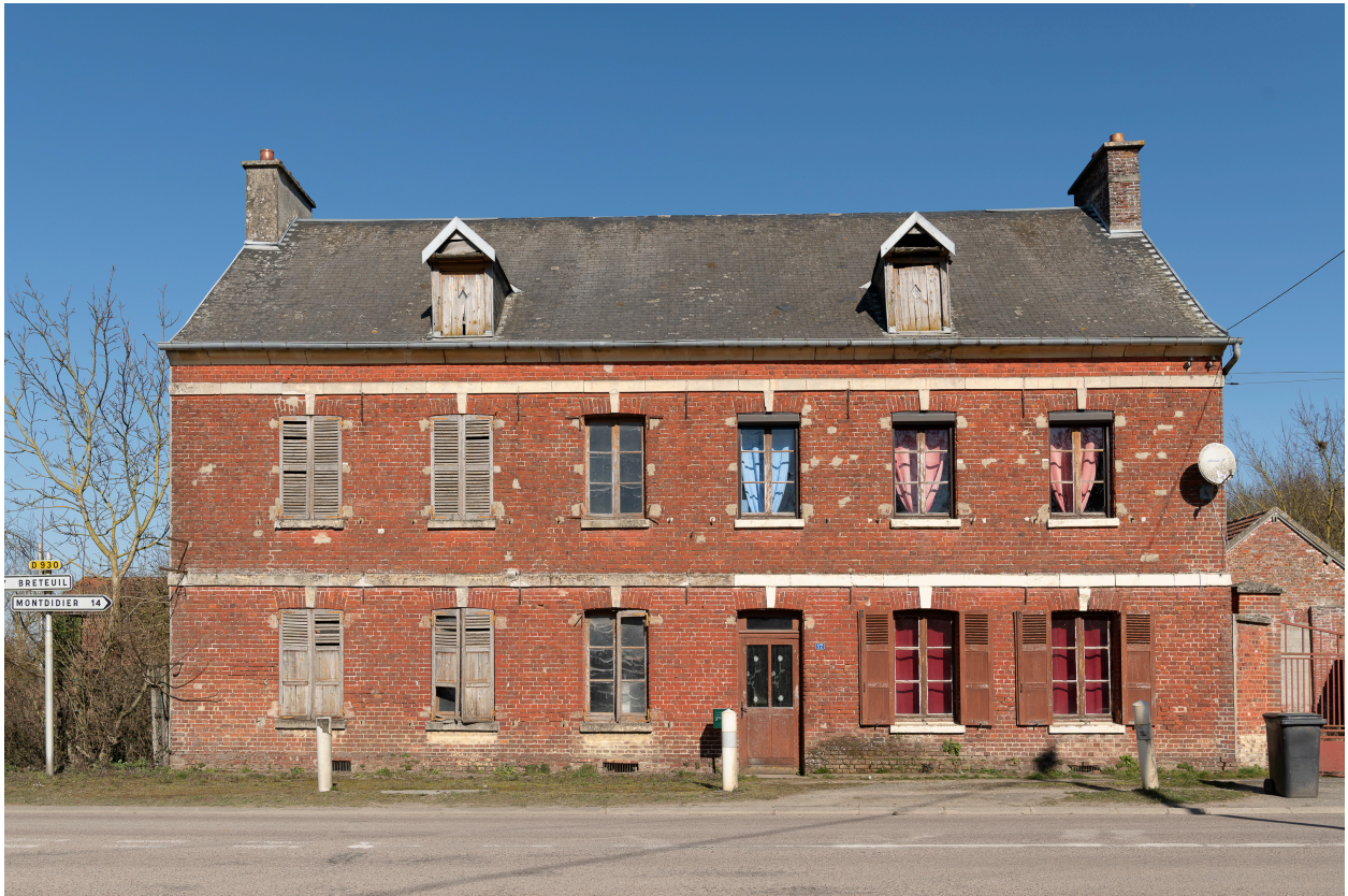
Ancienne laiterie, n°17 de la rue de Montdidier, vue depuis le sud.
