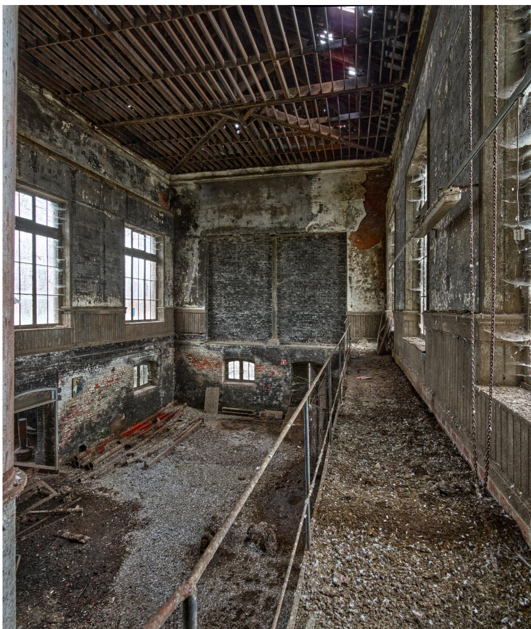
Vue intérieure de la salle des machines.
