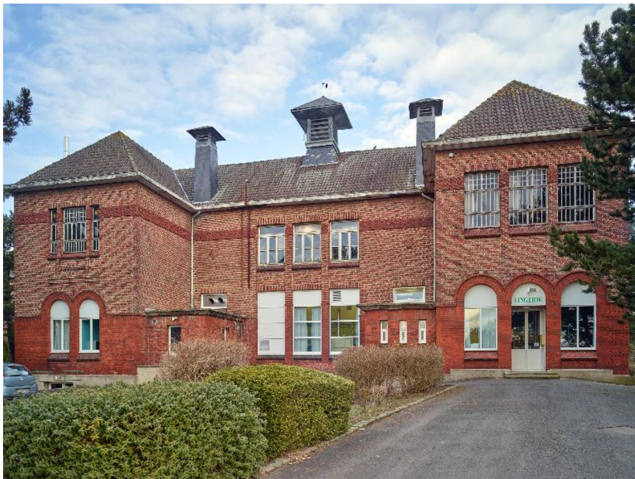
Buanderie-lingerie, élévation antérieure, vue générale prise de face.
