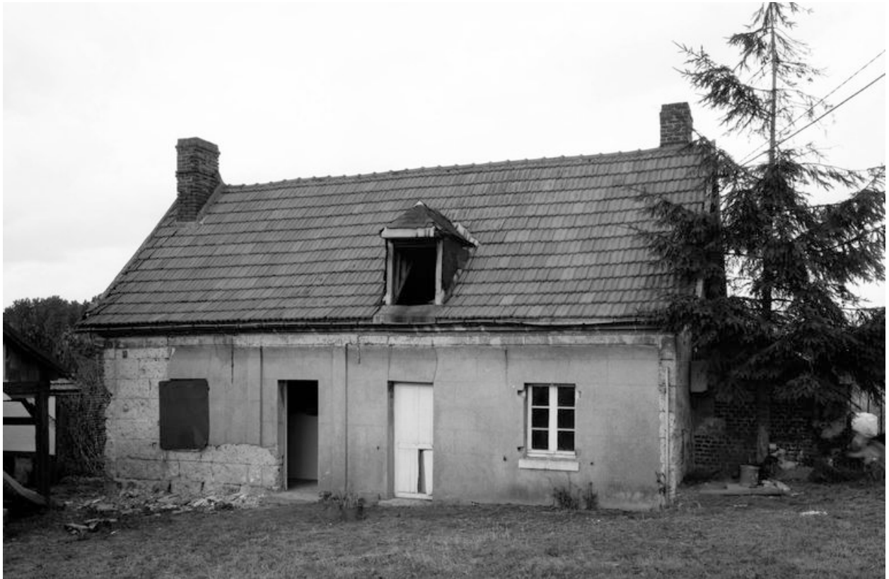
Logis. Élévation antérieure.
