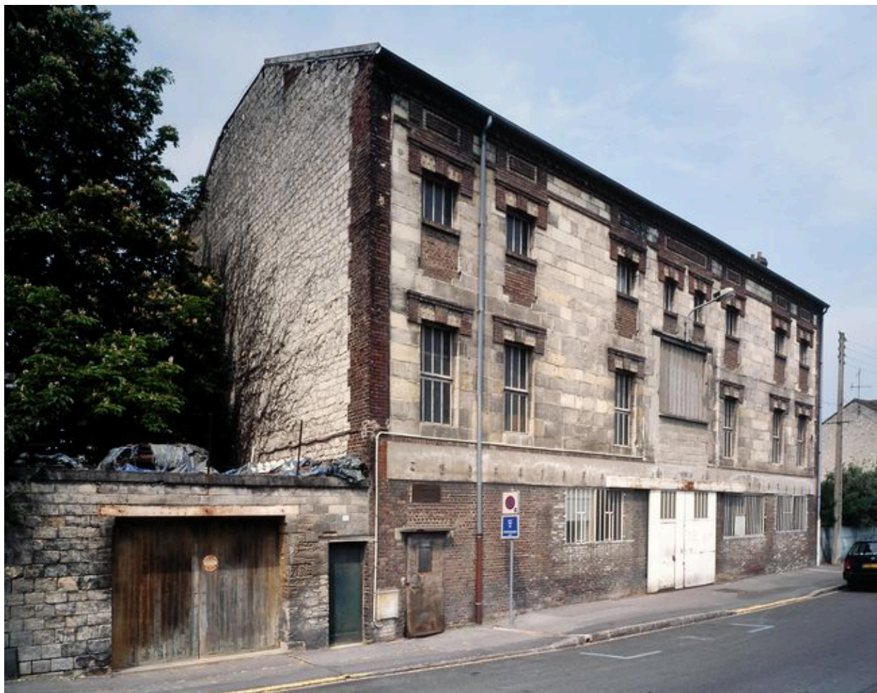
Ancien relais pour chevaux de halage intégré aux ateliers municipaux.
