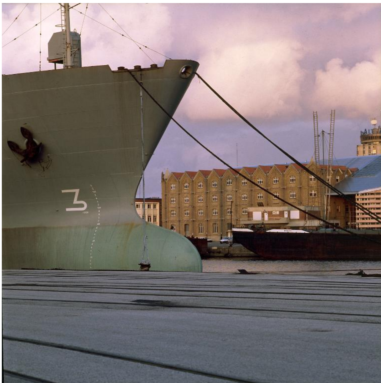
Vue générale, façades sur rue du Gros Jack et quai Freycinet.
