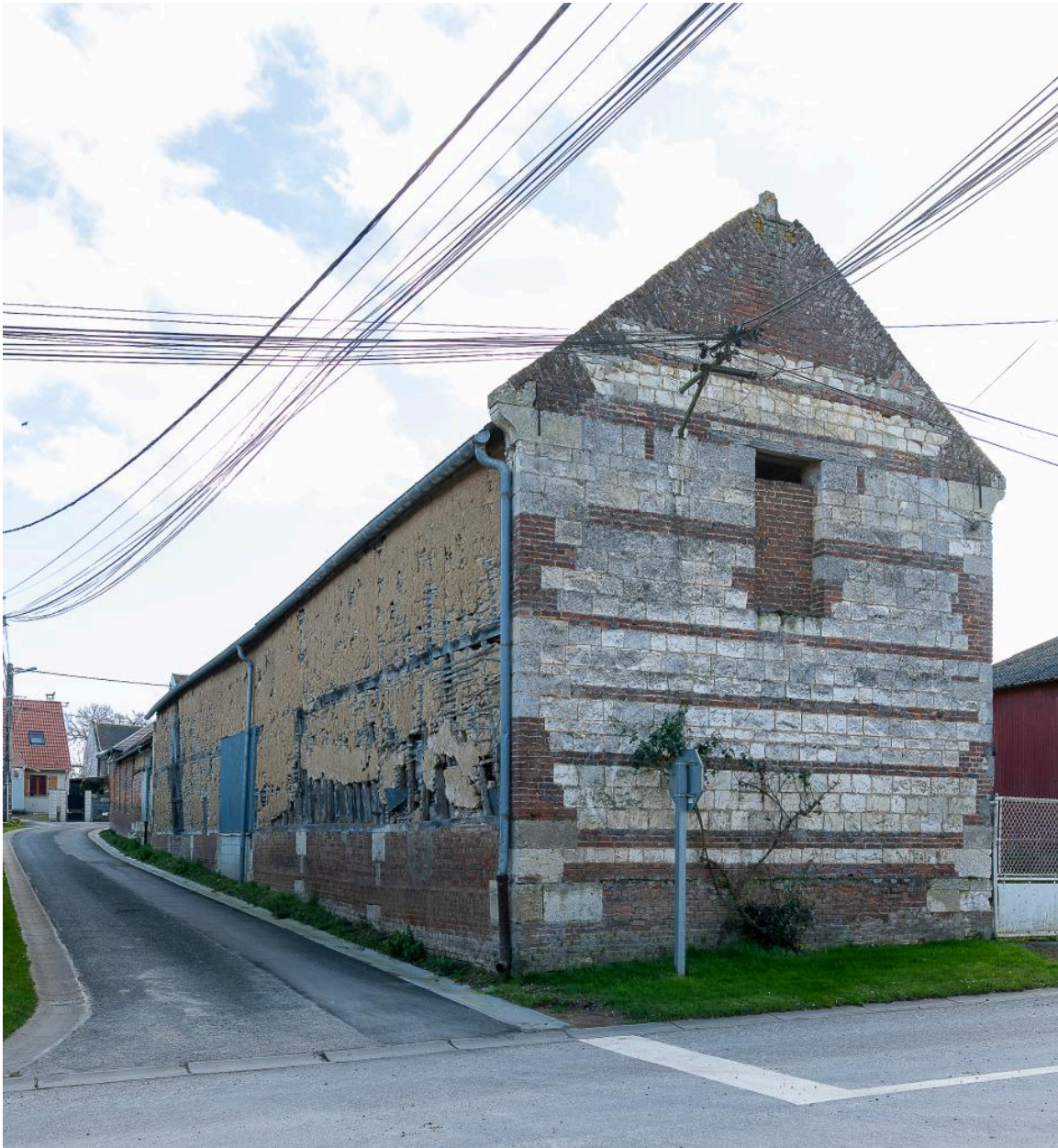
Bâtiments agricoles avec pignon en pierre et brique, n°39 Grande Rue, vue depuis le nord.
