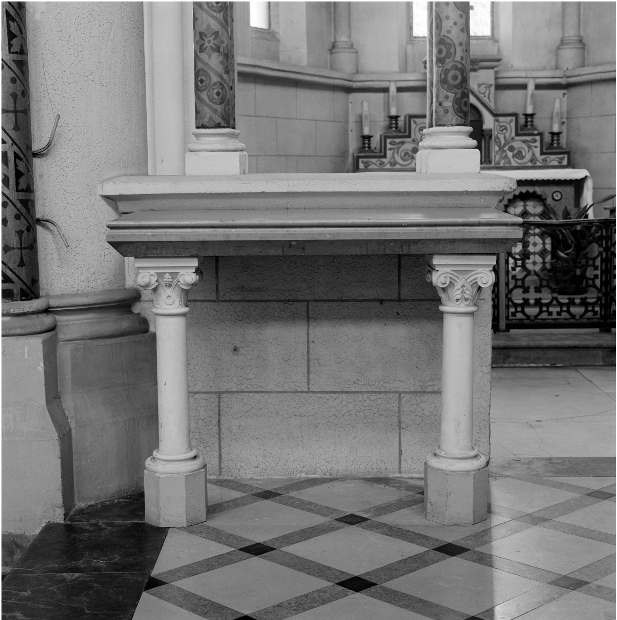
Crédences (2), vue générale d'un élément. Crédences autrefois placées près du maître-autel, pierre taillée peinte blanche, marbre de Marquise taillé, mouluré, 91 H, 117 L, 60 P.
