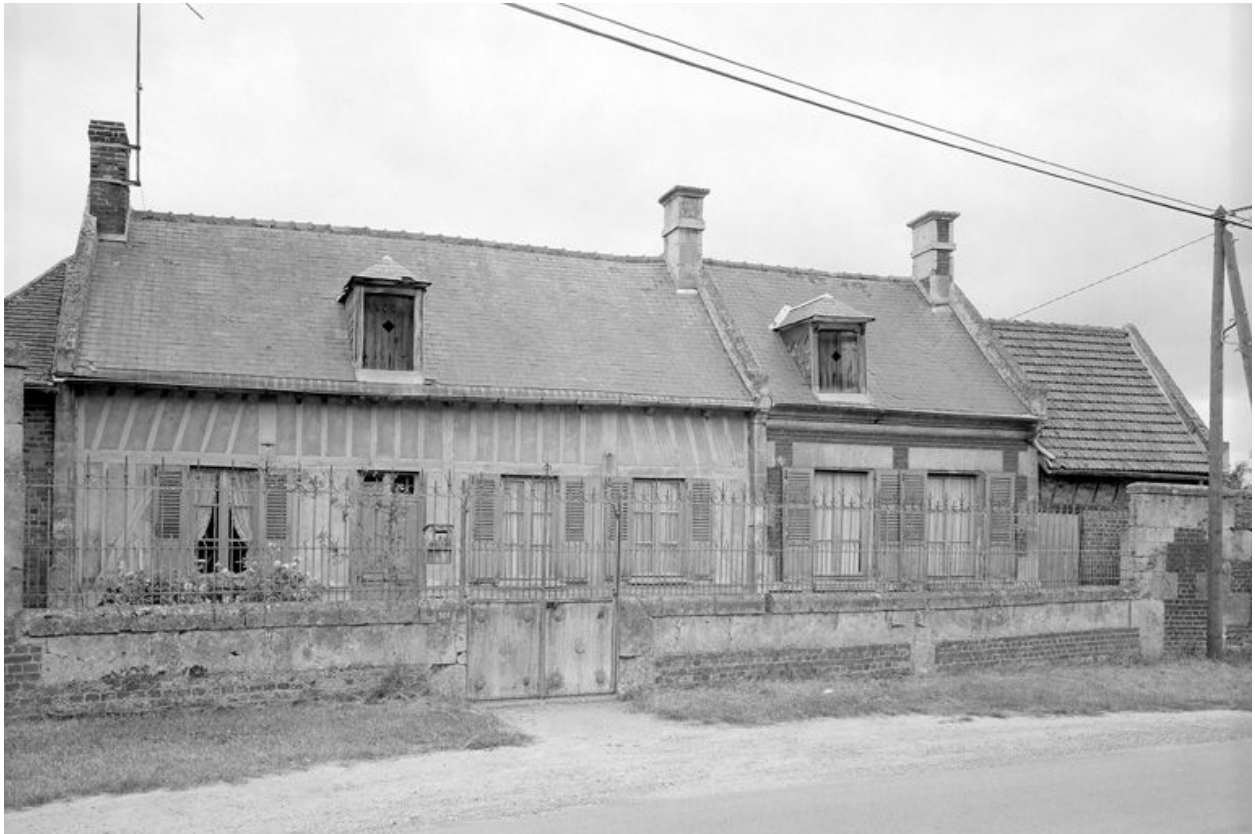
Logis. Élévation antérieure.
